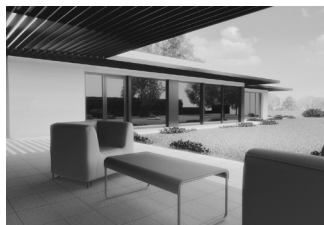
vivienda unifamiliar en Gorraiz
